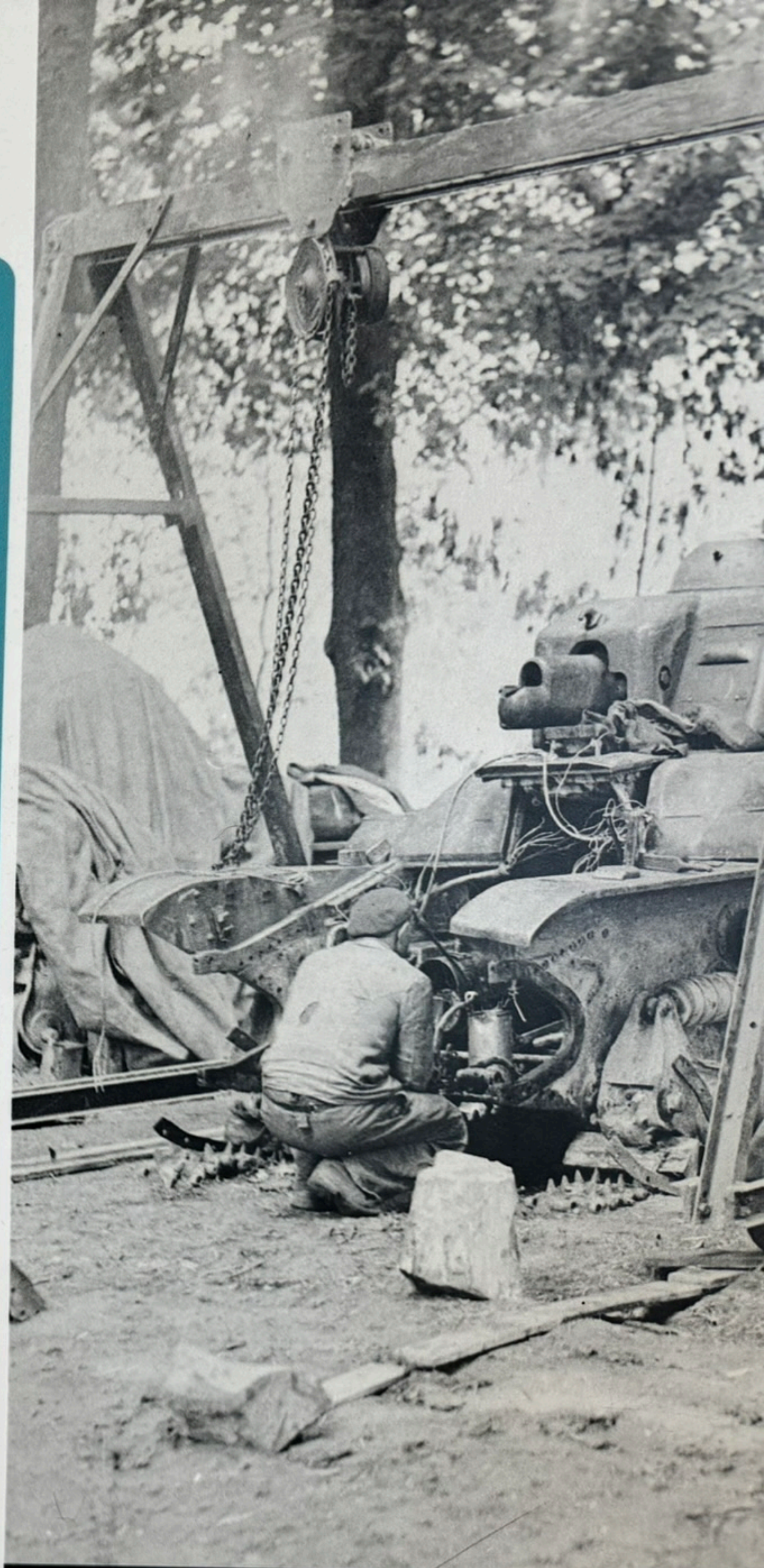
Un atelier de campagne dans les années 1930. Notez que le blindage avant est formé d'un seul bloc. © Auteu...
